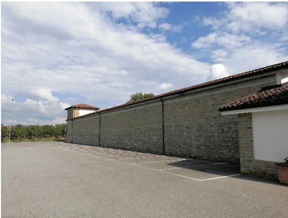
Recinzione ultimo ampliamento
