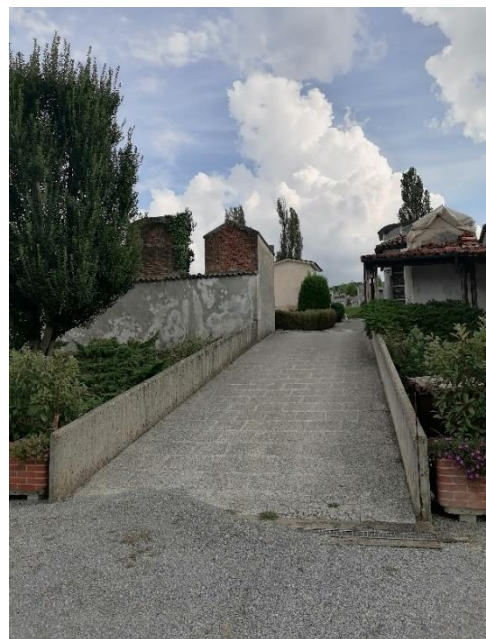
Rampa di collegamento ultimo ampliamento
