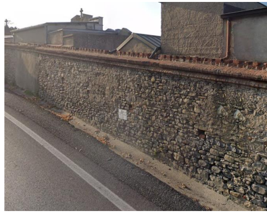
Muro perimetrale primo nucleo
