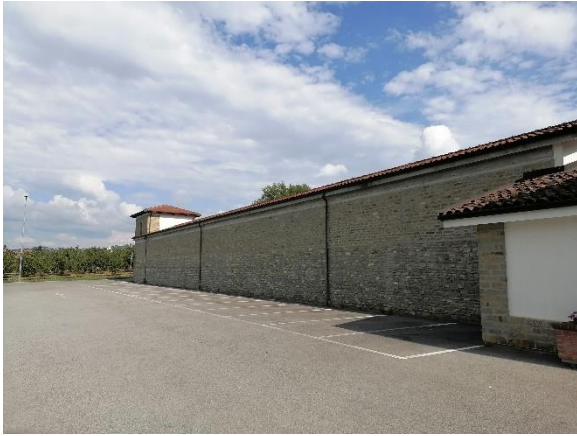
Muro perimetrale ultimo ampliamento
